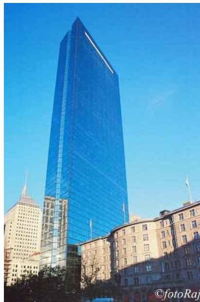
Figura 111 Torre Hancock, imagem exterior, Henry Cobb
