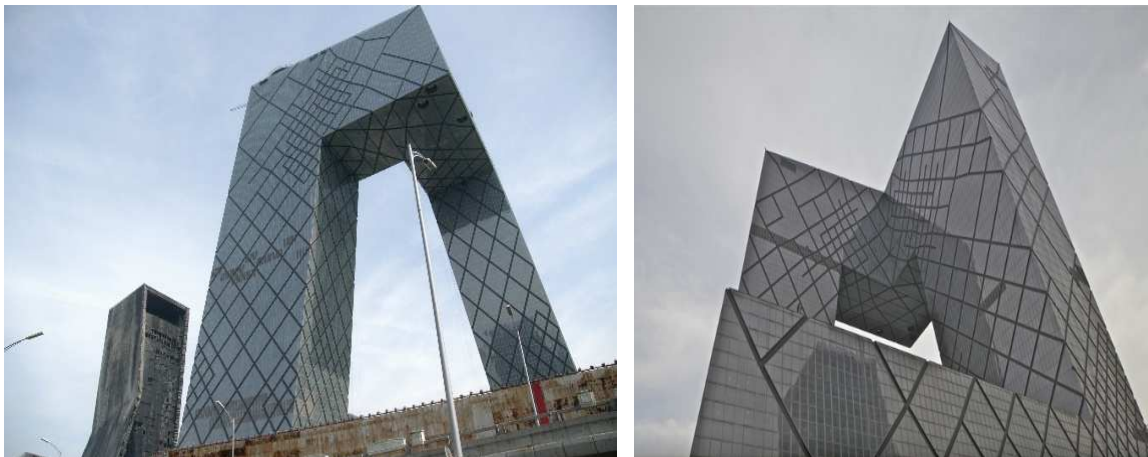
Figura 26 Edifício CCTV, OMA ( www.pinterest.pt ) As diferentes percepções da forma, e a representação estrutural em parte revelada na fachada exterior.
