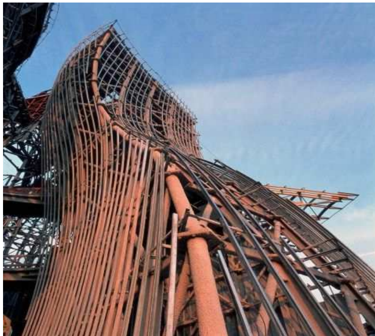
Figura 36 Guggenheim, estrutura metálica interior, Gehry. ( www.guggenheim-bilbao.es )
