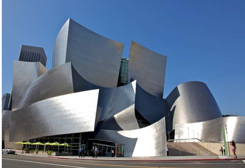
Figura 116 Sala de concertos da Disney, F. Gehry
