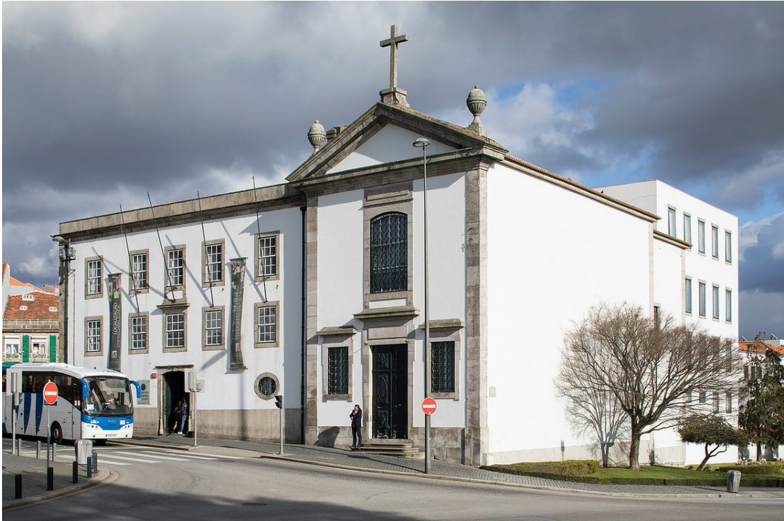
Figura 48: Vista da Universidade Lusófona do Porto
