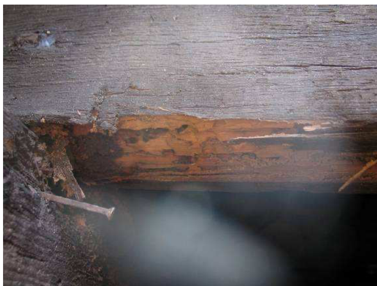
Figura 36 e 37: Degradação da madeira nas coberturas
