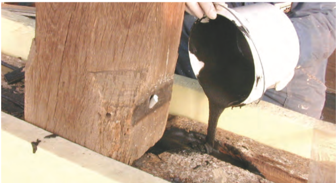
Figura 30: Reforço da cobertura com a aplicação de resinas epóxicas
