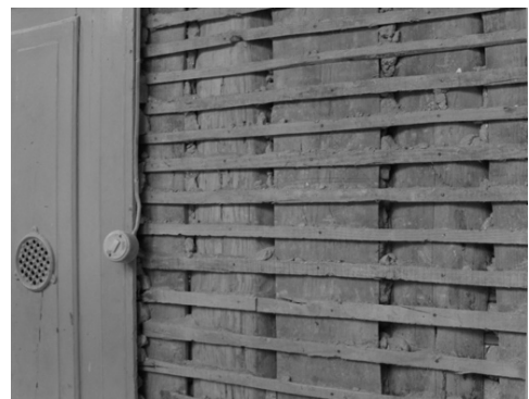
Figura 29: Paredes interiores com tabiques
