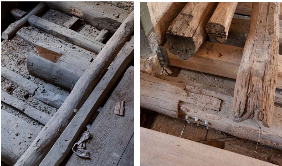
Figura 19 e 20: Reparação de vigas usando próteses de madeira
