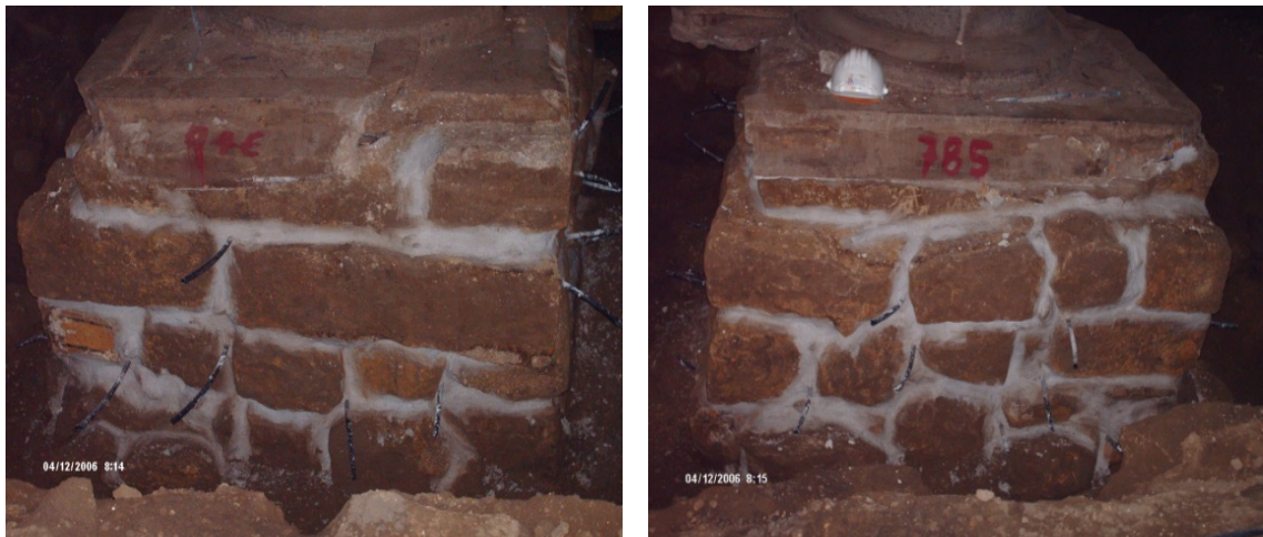
Figura 4 e 5: Consolidação de fundações, Igreja de Caminha
