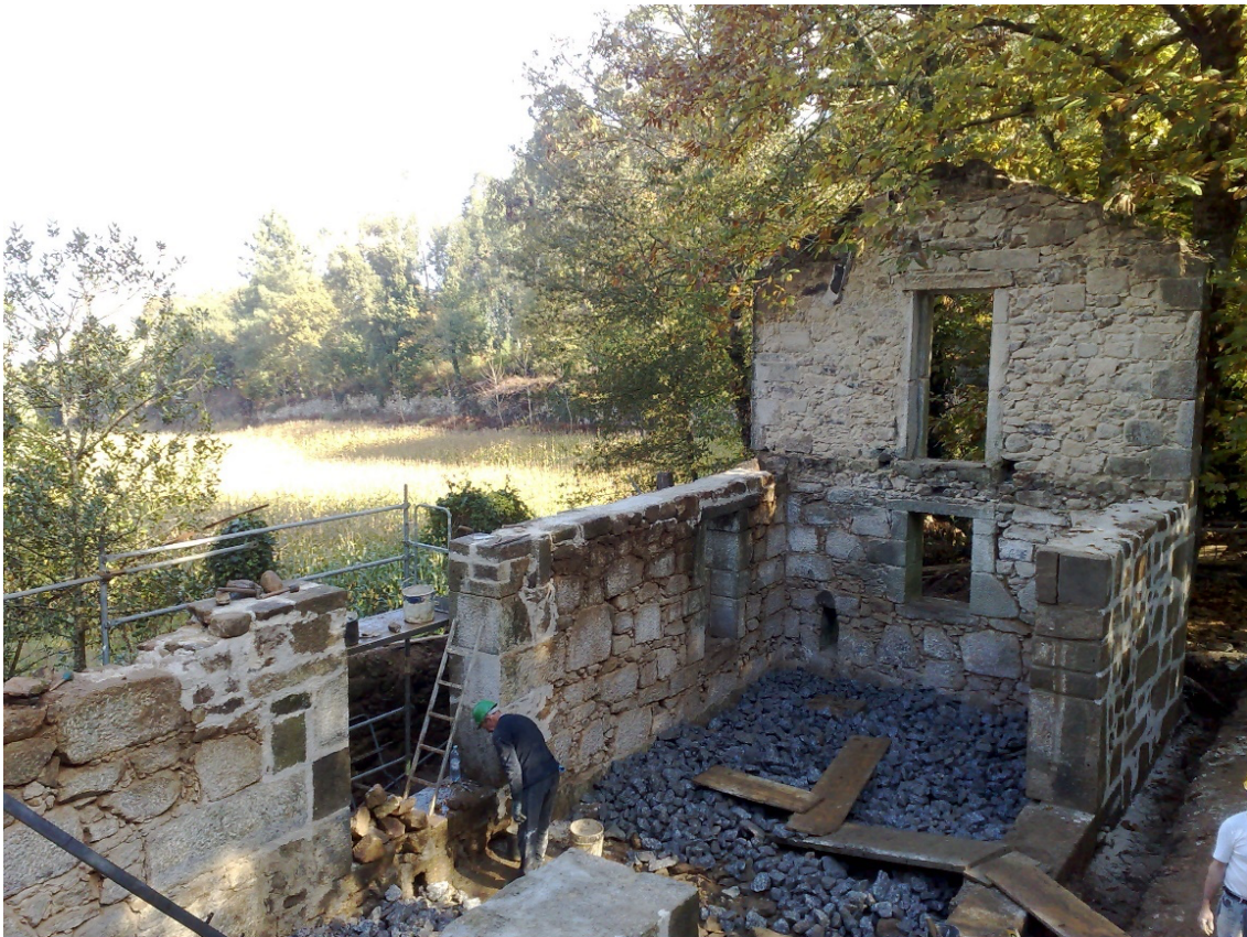
Figura 23: Refechamento de juntas em alvenaria de pedra
