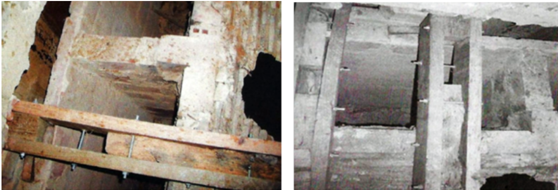
Figura 16 e 17: Técnica de reforço com elementos metálicos
