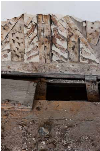
Figura 44: Parede interior em tabiques
