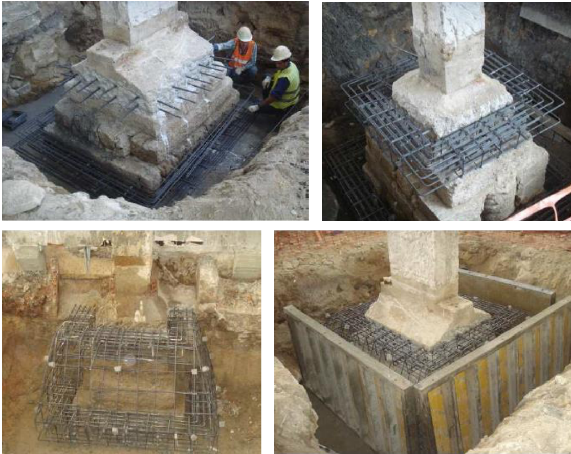
Figura 6, 7, 8 e 9: Reforço das fundações por alargamento
