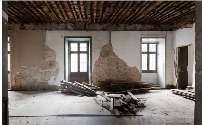
Figura 45: Parede exteriores em alvenaria de pedra
