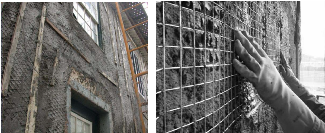
Figura 26 e 27: Rebocos armados em paredes exteriores
