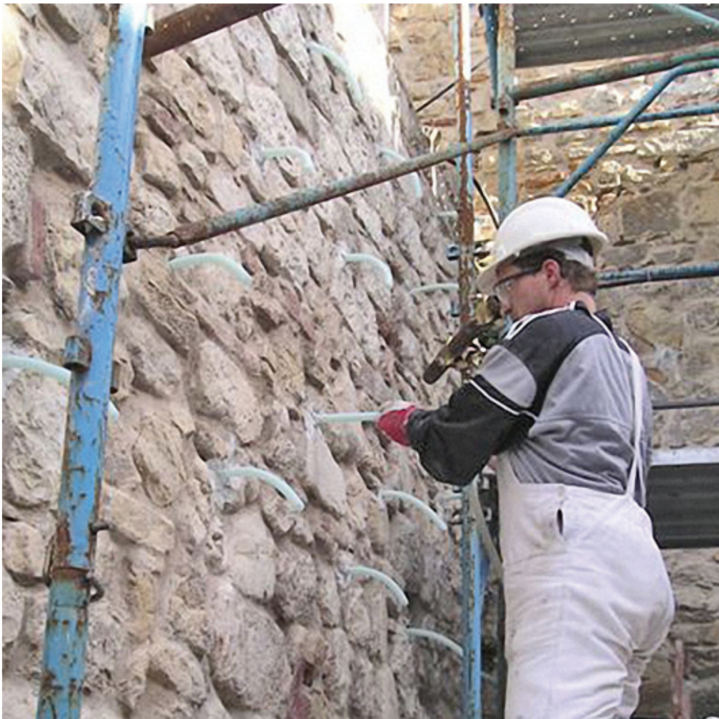
Figura 21: Técnica de injeção de resina em paredes de alvenaria
