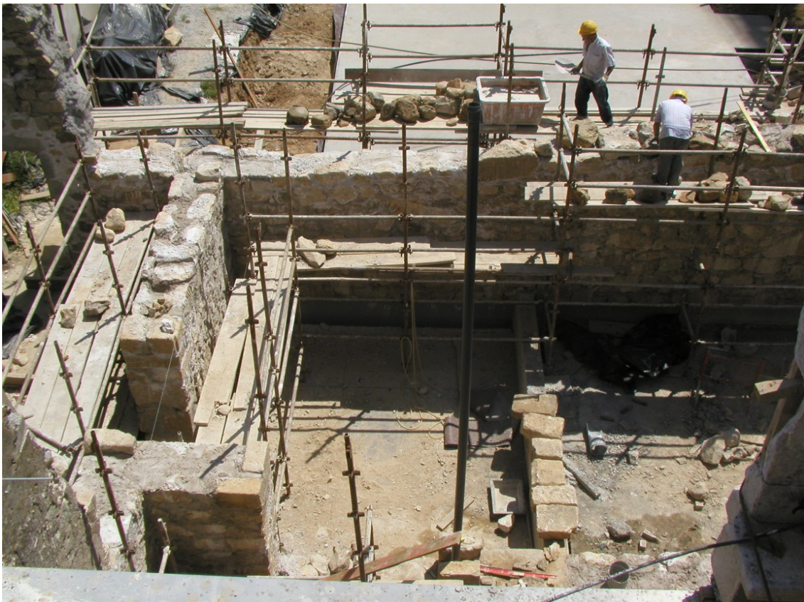
Figura 22: Reconstrução de alvenaria
