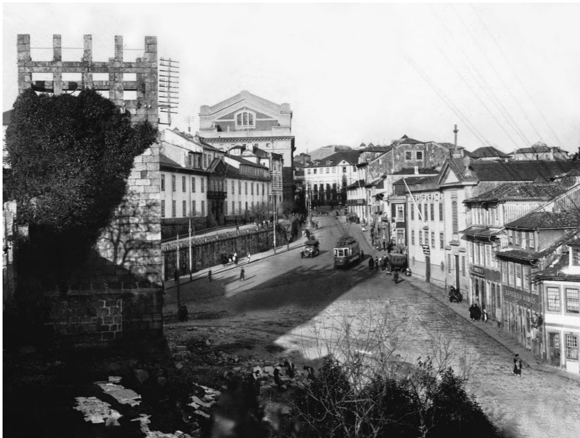
Figura 47: Vista da Universidade Lusófona do Porto antes da construção do viaduto
