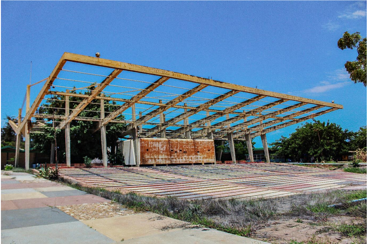
Figura 46. Cine-esplanada Flamingo. Pormenor da estrutura do betão e da cabine de projeção; Fonte: Autor.
