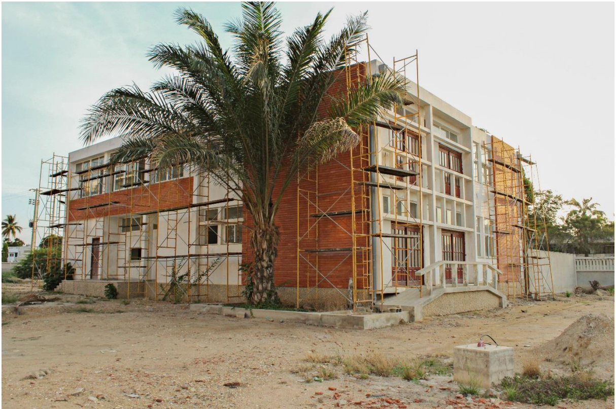
Figura 50. Liceu do Lobito. Edifício Administrativo; Fonte: Autor.
