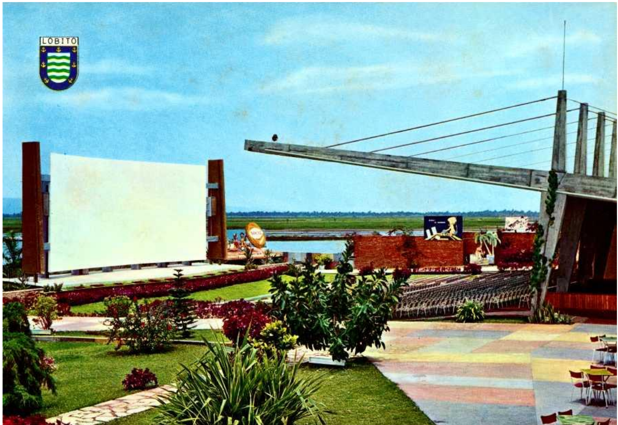
Figura 42. Cine-esplanada Flamingo. Estrutura que funcionava como cobertura de sombreamento; Fonte: (Oliveira, 2008).
