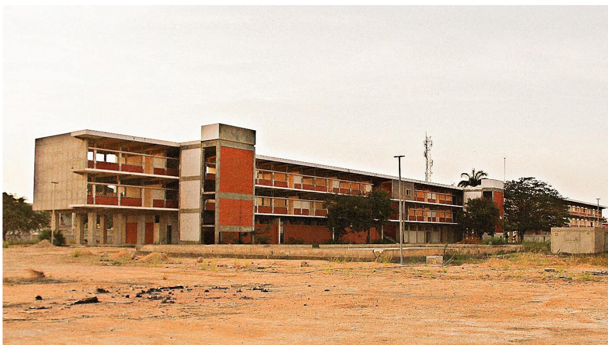
Figura 53. Liceu do Lobito. Segundo bloco, correspondente as salas de aulas do 2º e 3º ciclo; Fonte: Autor
