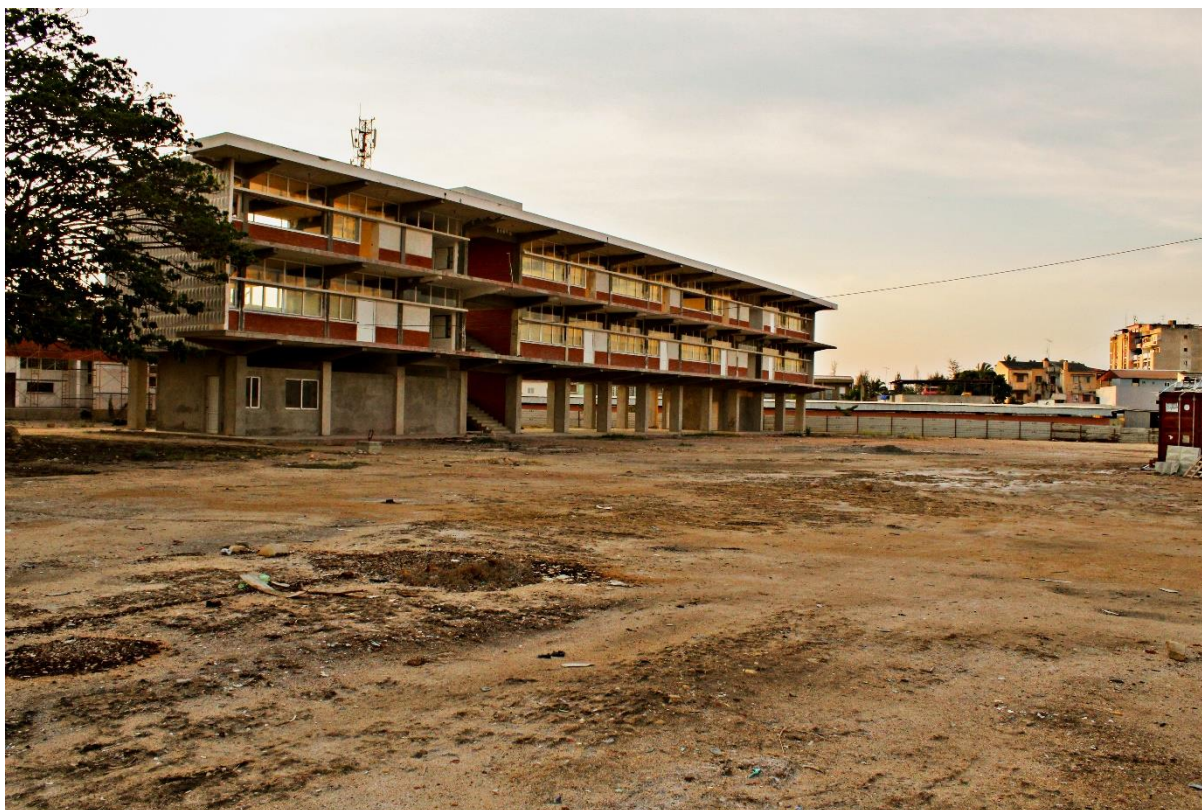
Figura 52. Liceu do Lobito. Primeiro bloco, correspondente ao núcleo de salas de aulas do 1º ciclo; Fonte: Autor.
