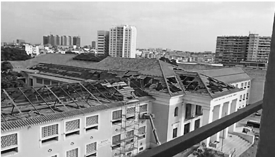
Figura 66. Liceu Muto-ya-Kevela antes da reabilitação; Fonte: (Agency, 2018)
