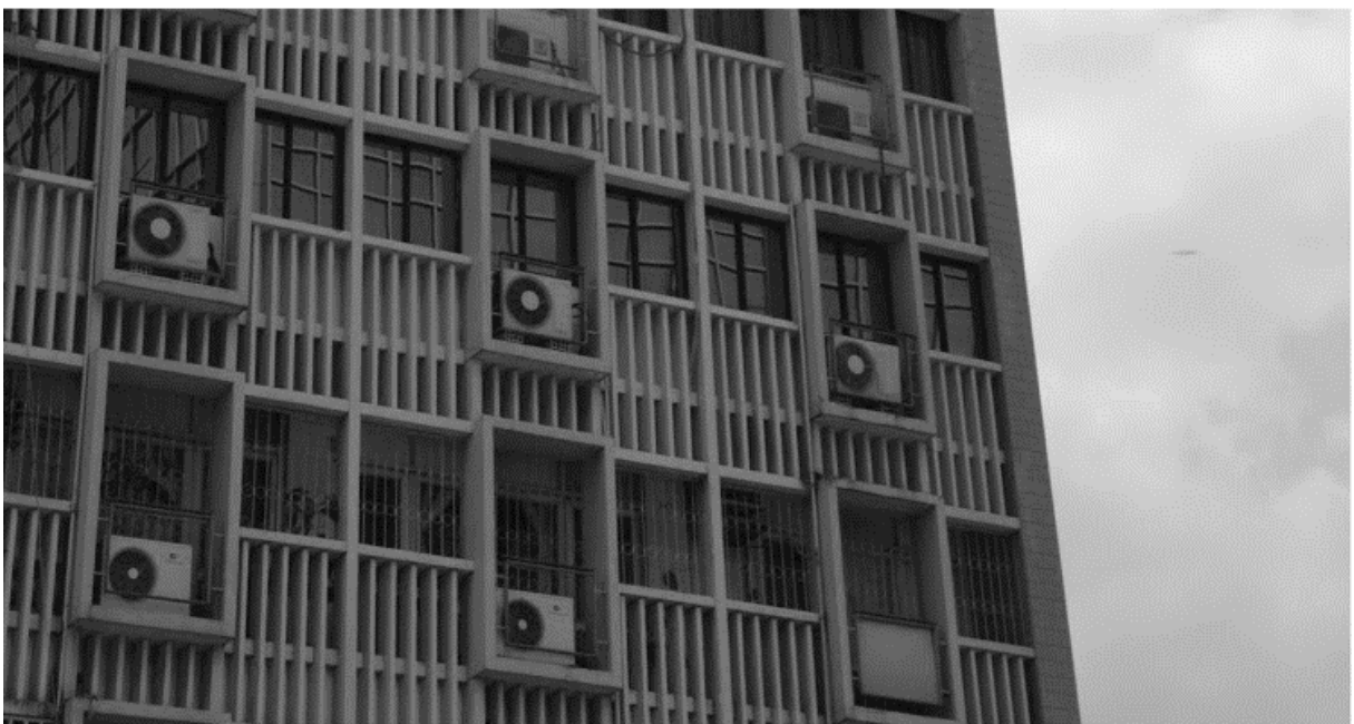
Figura 13. Edifício Habitacional, Luanda; Fonte: (Freches, 2012)
