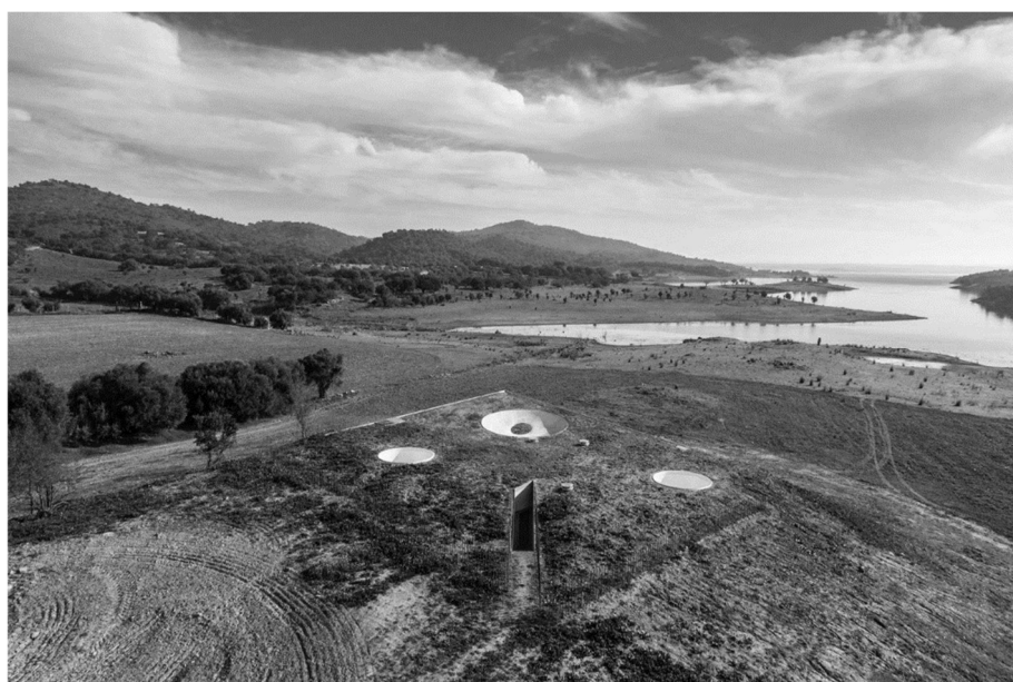
Figura 80 - Vista aérea_ Casa em Monsaraz
