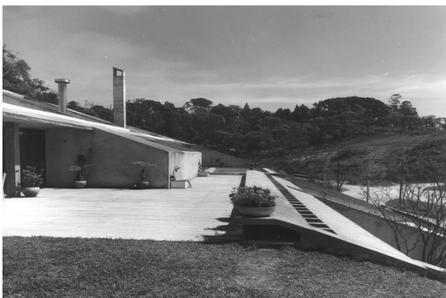
Figura 26 - Vista sob a paisagem_2.º Piso_ Residência Sigrist
