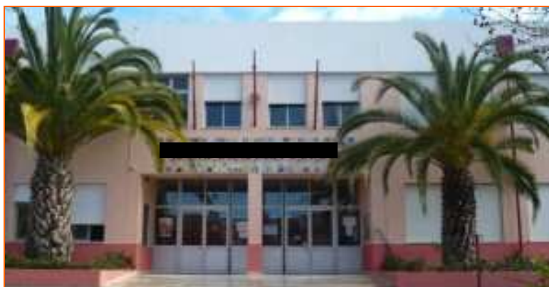
Figura 14 – Fachada da Escola A. Fonte: site do estabelecimento de ensino.
