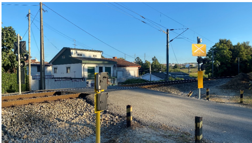
Figura 38. Passagem de nível na Travessa Bouça da Cal
