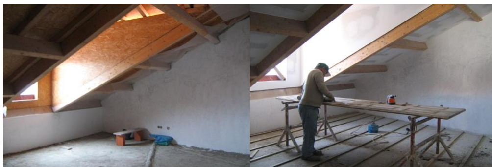
Figura 150 – Fotos da estrutura da cobertura em madeira e acabamento em gesso cartonado. Fonte: Fotos Cedidas pelo gabinete Floret Architectura
