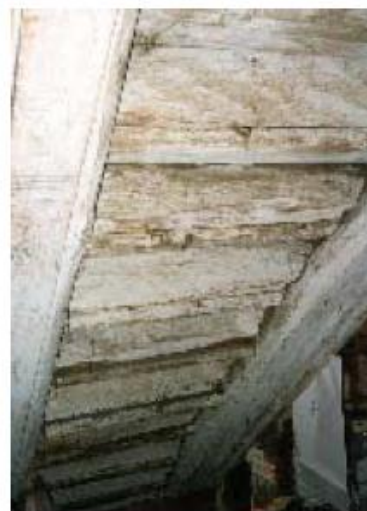
Figura 76 – Vista interior de um lanço de escadas, sem revestimento, onde se pode observar as pernas, os cobertores e os espelhos dos degraus. Foto de grupo de trabalho do ano 2001/2002 FAUP. Fonte: (Teixeira, 2004)
