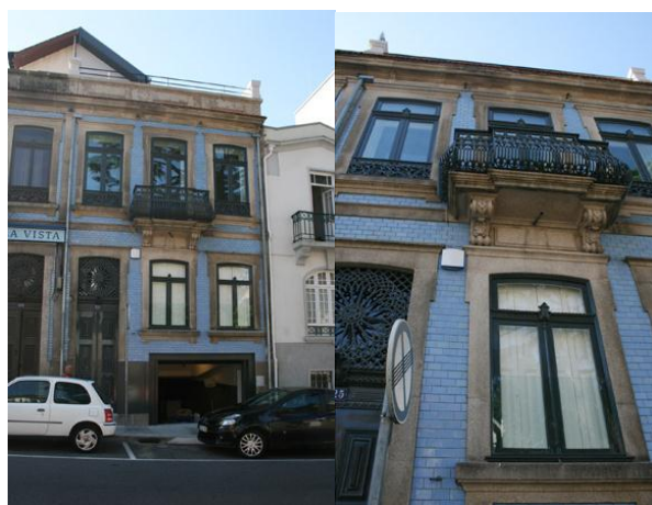
Figura 129 – Fotos da fachada principal Fonte: Autor
