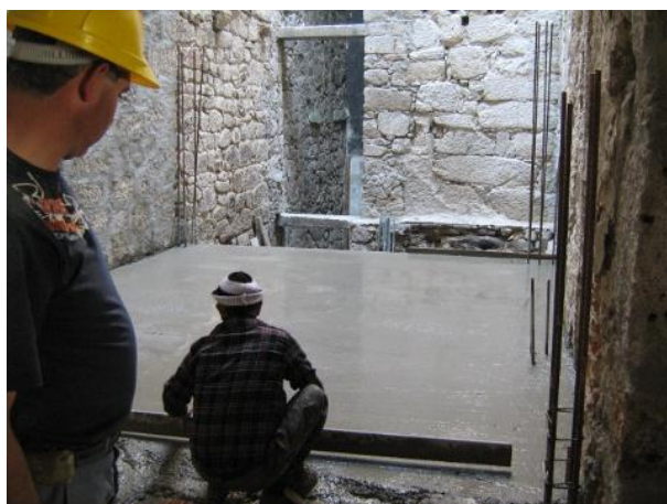
Figura 140 – Fotos de estrutura aligeirada de betão. Fonte: Foto cedida pelo gabinete Floret Architectura
