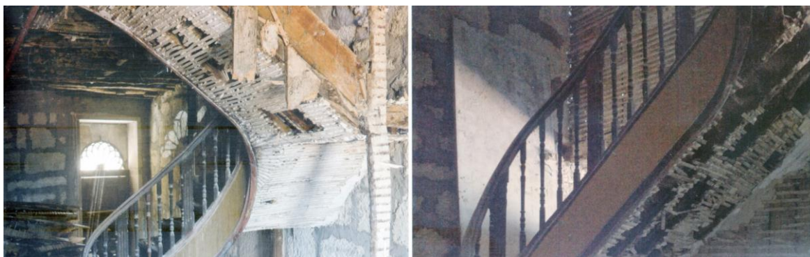
Figura 72 – Escada em fase de intervenção de reabilitação. Fonte: Peixoto de Freitas (2012)
