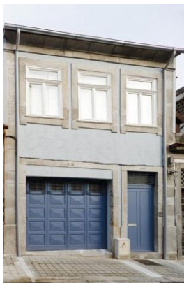
Figura 161 – Foto fachada principal Fonte: fotos do autor
