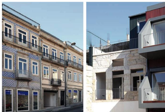
Figura 106 – Fachada principal e pormenor da de tardoz Fonte: Autor
