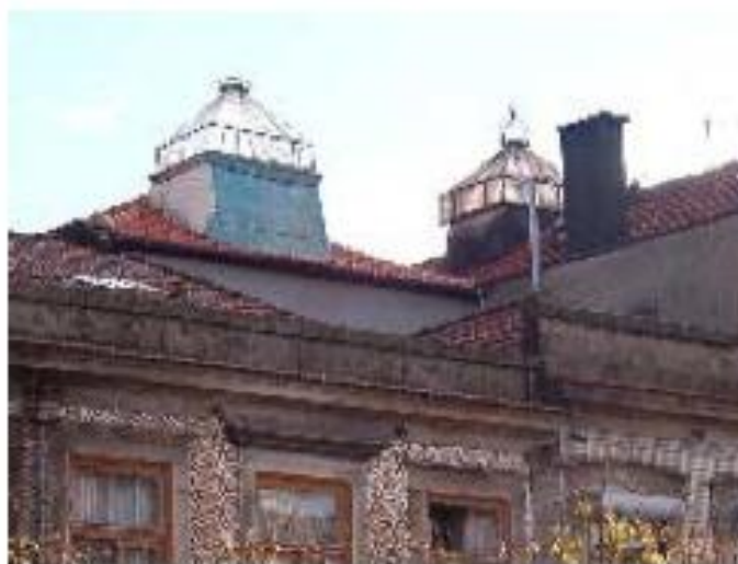
Figura 51 – Clarabóia e lanternim de forma quadrangular de casas localizadas na rua do Barão de S. Cosme. Fonte: Foto de grupo de alunos do ano letivo 2002/2003 da FAUP (Teixeira, 2004).
