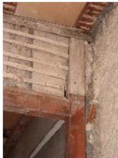
Figura 68 – Pormenor da padieira de um vão interior de porta. Foto de grupo de trabalho do ano 2002/2003 FAUP. Fonte: (Teixeira, 2004)
