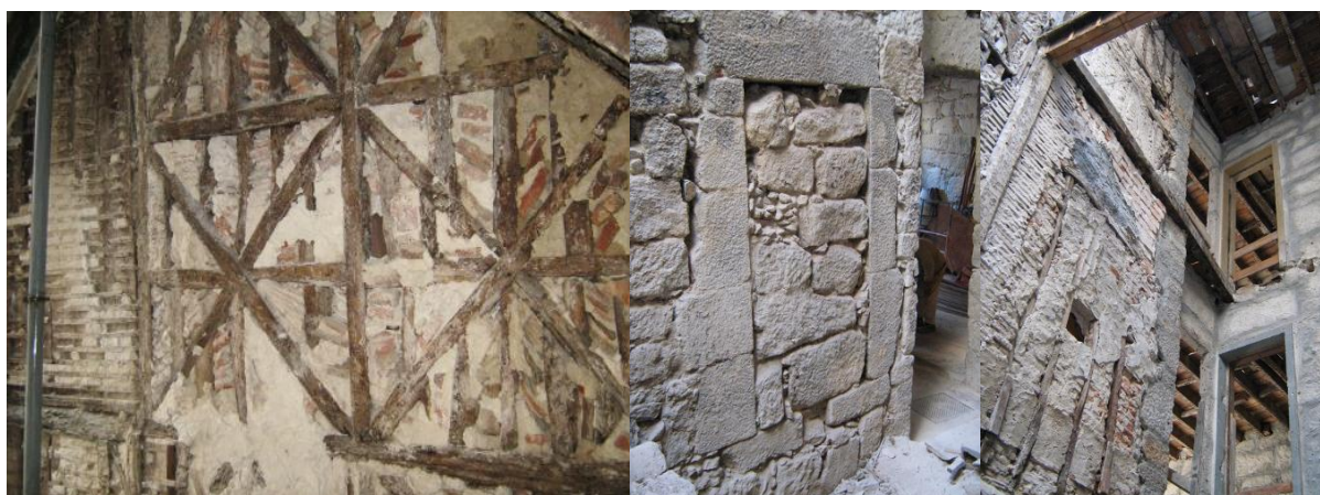
Figura 139 – Fotos das paredes interiores em tabique e alvenaria de pedra Fonte: Fotos cedidas pelo gabinete Floret Architectura
