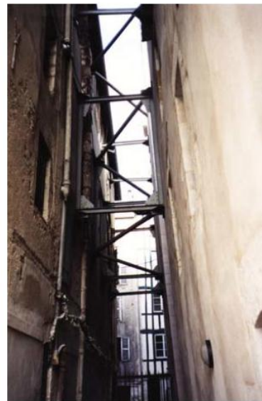
Figura 98 – Escoramento de fachadas Fonte: autor desconhecido
