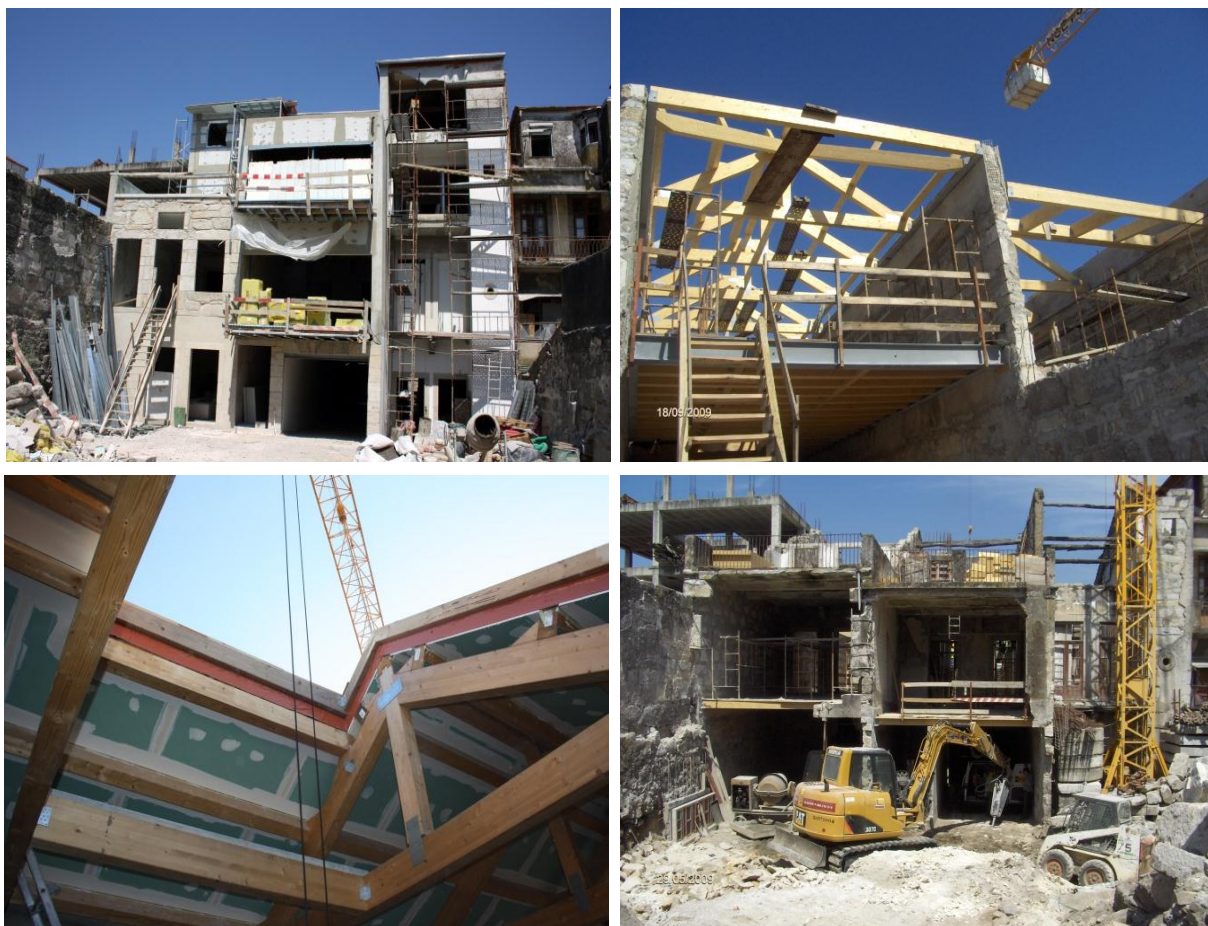
Figura 109 – Fotos referentes ao decorrer das obras. Fonte: Fotos cedidas pelo gabinete Minimalinea.
