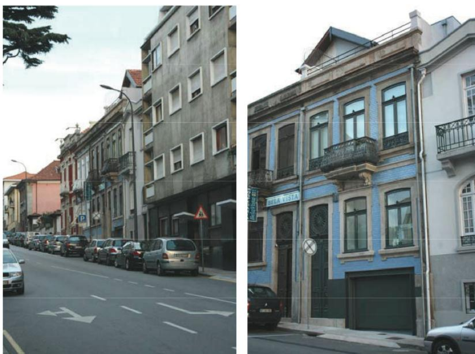
Figura 125 – Vista da Rua Nossa Senhora de Fátima Fonte: Autor
