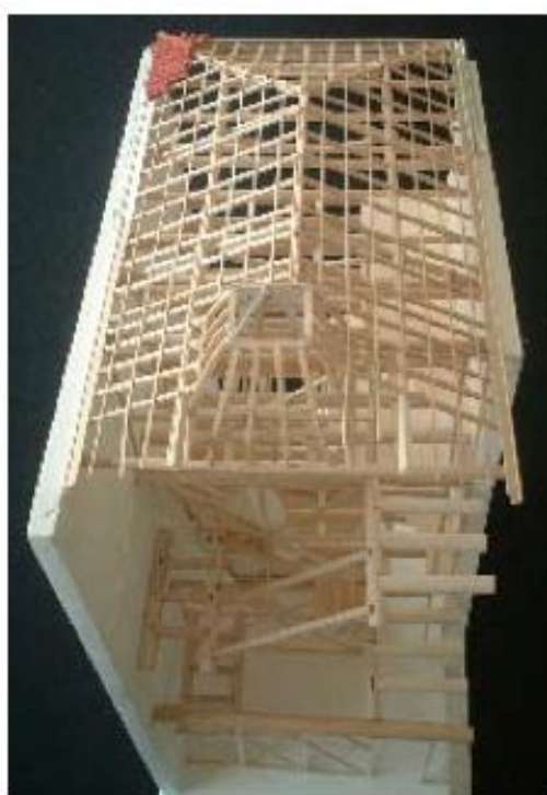
Figura 53 – Pormenor da estrutura de uma claraboia quadrangular com as paredes arqueadas e lanternim piramidal em estrutura metálica. Maqueta realizada por um grupo de alunos do ano 1999/2000 FAUP. Fonte: (Teixeira, 2004)
