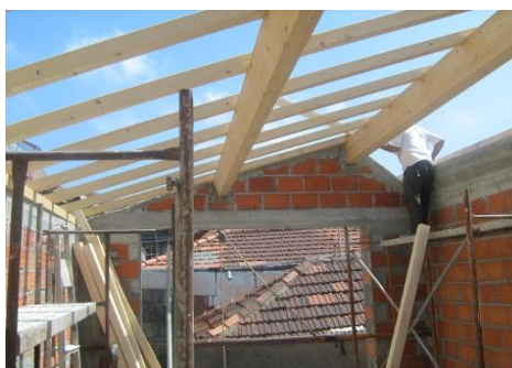
Figura 149 – Foto da estrutura da cobertura em madeira. Fonte: Foto Cedida pelo gabinete Floret Architectura
