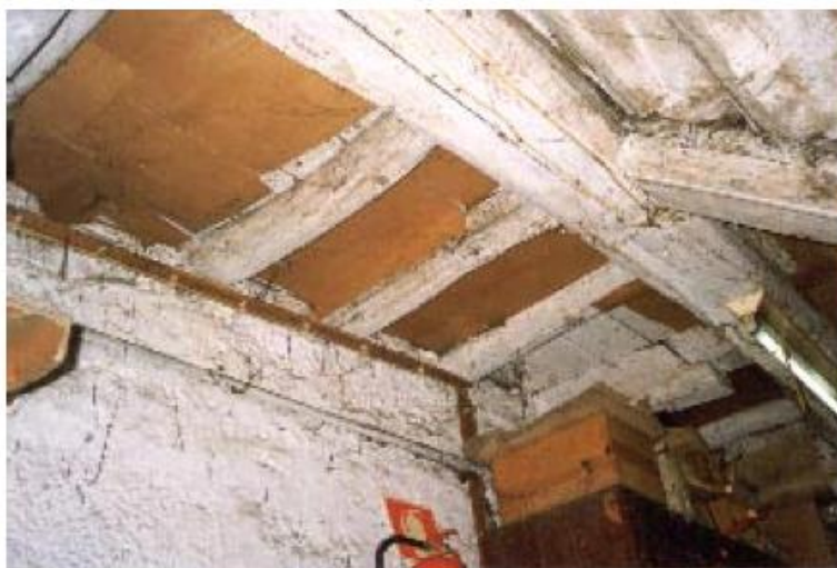
Figura 75 – Vista interior de patamar e escadas, onde se pode observar a cadeia a servir de apoio a uma das pernas das escadas e aos chinchareis que apoiam diretamente na parede de meação. Foto de grupo de trabalho do ano 2001/2002 FAUP. Fonte: (Teixeira, 2004)
