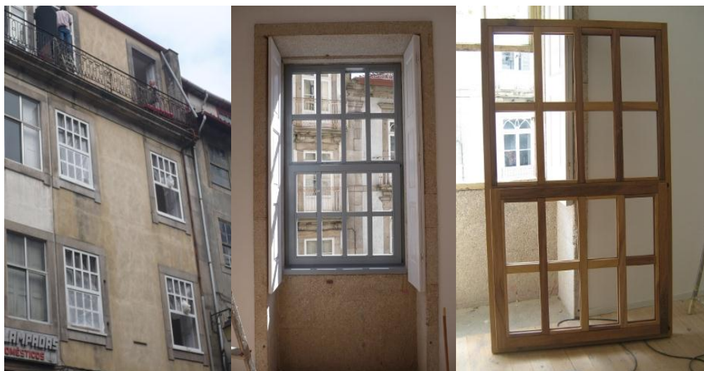
Figura 147 – Fotos das caixilharias de guilhotina de duas folhas Fonte: Fotos cedidas pelo gabinete Floret Arquitectura
