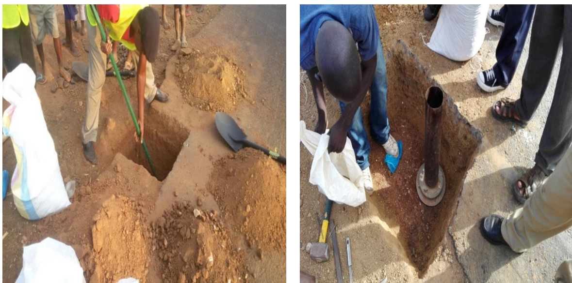
Figura 9 – Escavação de poços de ensaio e recolha de amostras [Fotos: cortesia de Roughton International Ltd.]
