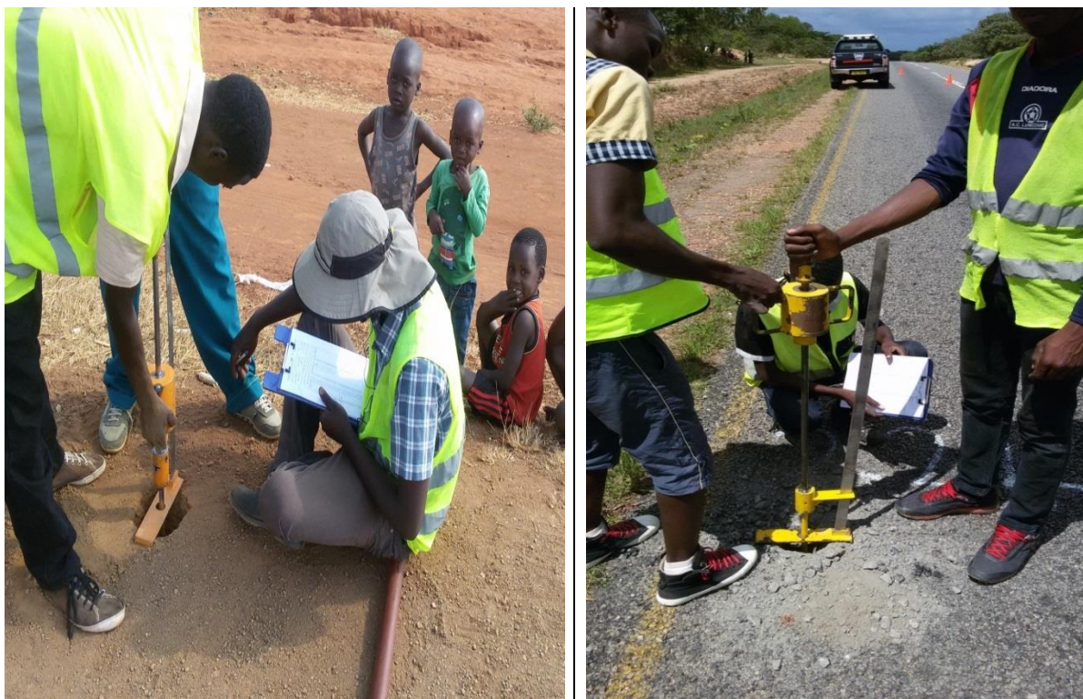
Figura 11 – Ensaio DCP realizado na rodovia M1, Malawi [Fotos: cortesia de Roughton Internacional Ltd.]
