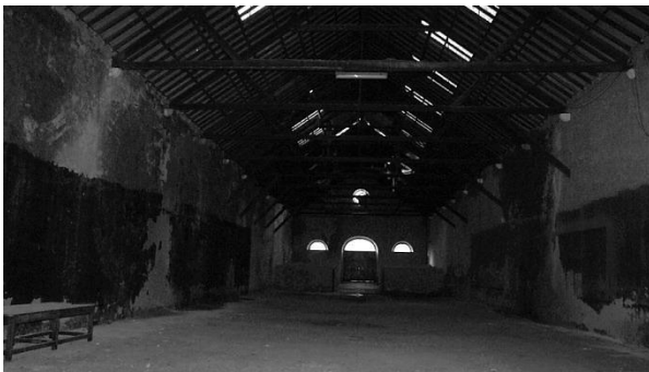
Fig. 134 – Entrada este, armazém 8.
