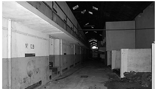
Fig. 120 – Galeria de Cubas.
