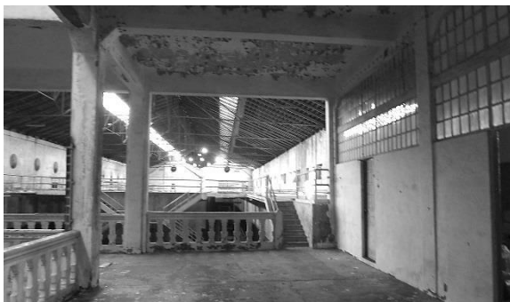
Fig. 177 – Ligação entre o armazém 3 e 2.
