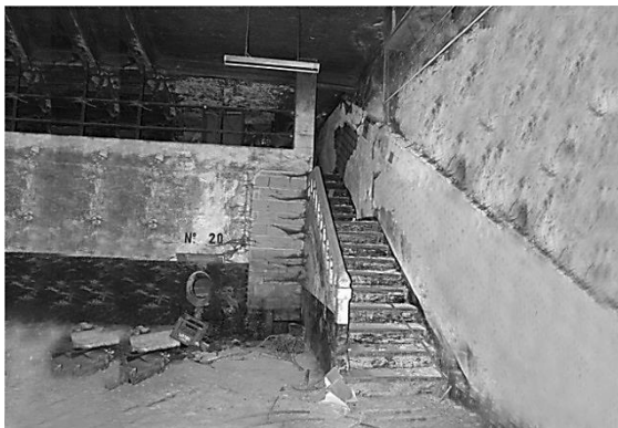
Fig. 107 – Antiga ligação entre armazéns.
