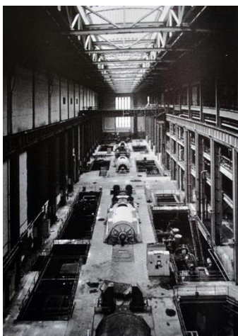
Fig. 7 – Vista geral da sala das turbinas.
