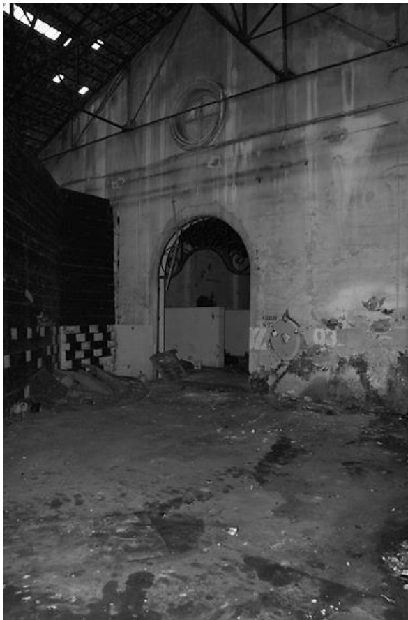
Fig. 140 – Entrada este, armazém 10.
