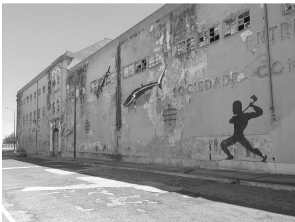
Fig. 211 – Edifício dedicado aos escritórios.
