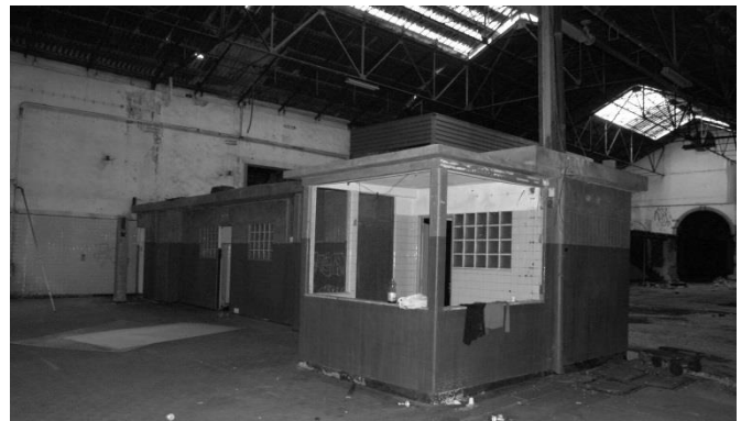
Fig. 127 – Instalações sanitárias Armazém 9.
