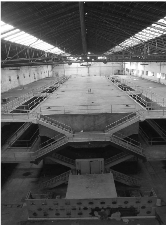
Fig. 190 – Vista para o armazém 2.
