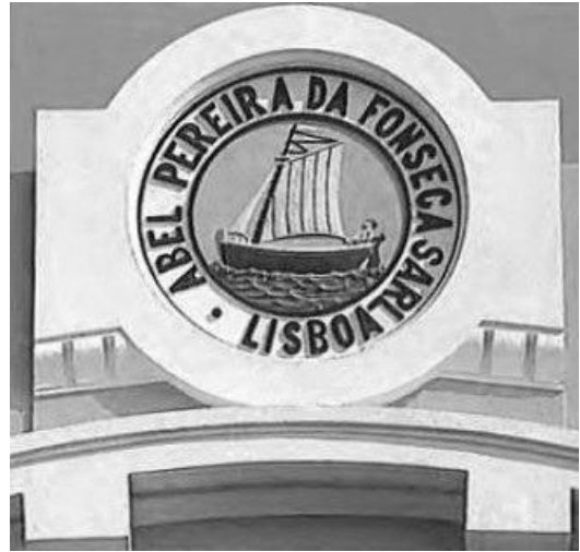
Fig. 49 – Frontão – fachada do armazém principal.
