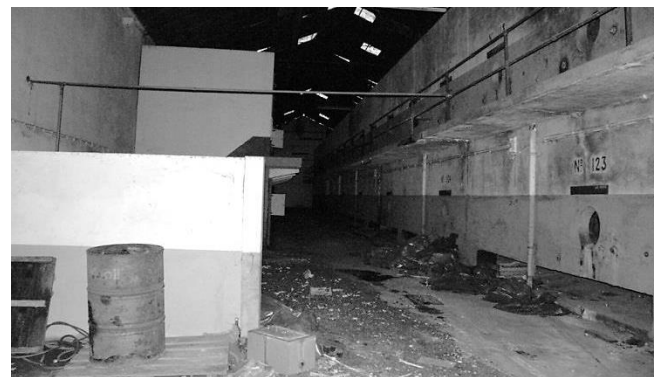
Fig. 121 – Galeria de Cubas.
