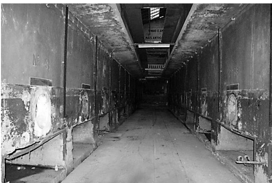
Fig. 109 – Galeria de cubas.
