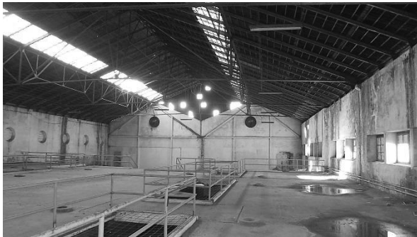
Fig. 170 – Vista para o armazém 1.
