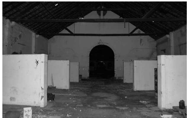
Fig. 141 – Entrada Oeste, armazém 10.
