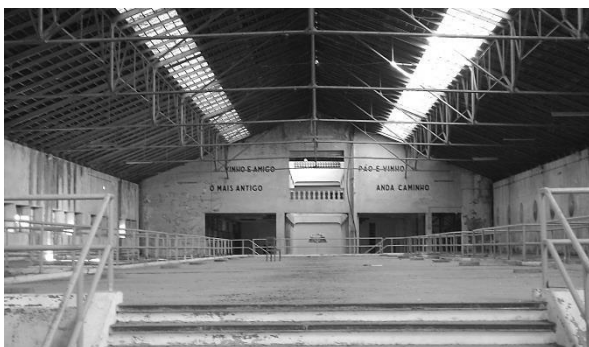
Fig. 173 – Vista para o armazém 3.
