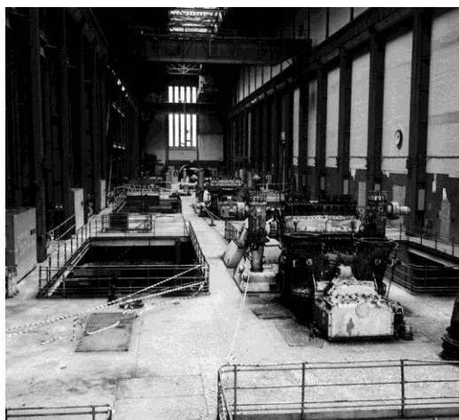
Fig. 8 – Vista geral da sala das turbinas, 1995.
