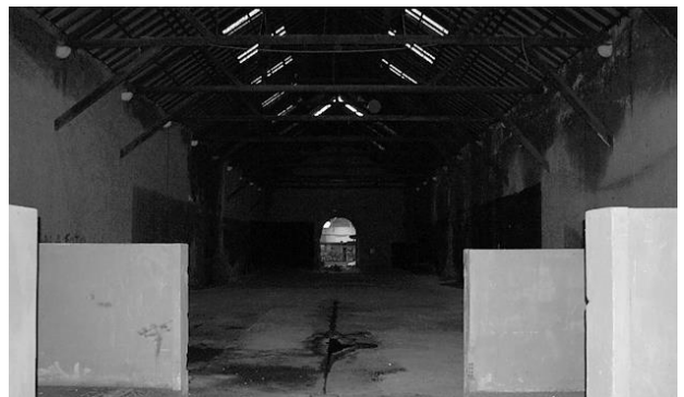
Fig. 136 – Entrada oeste, armazém 8.
