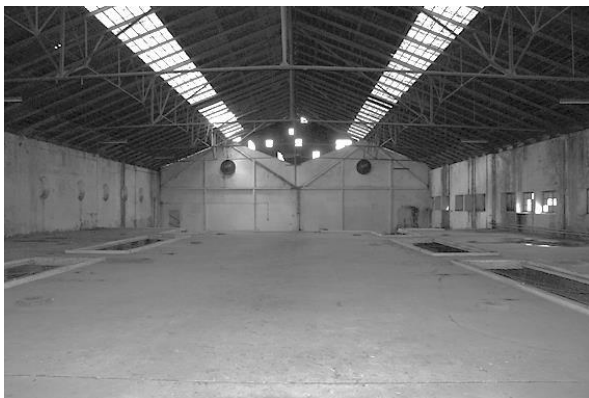
Fig. 171 – Vista para o armazém 1.
