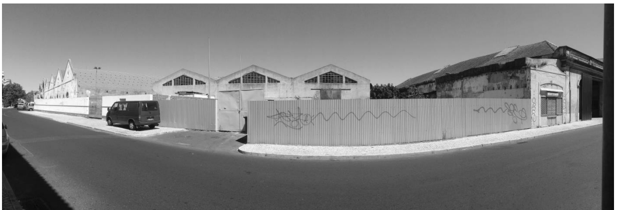
Fig. 208 – Armazéns ladeados aos anteriores.
