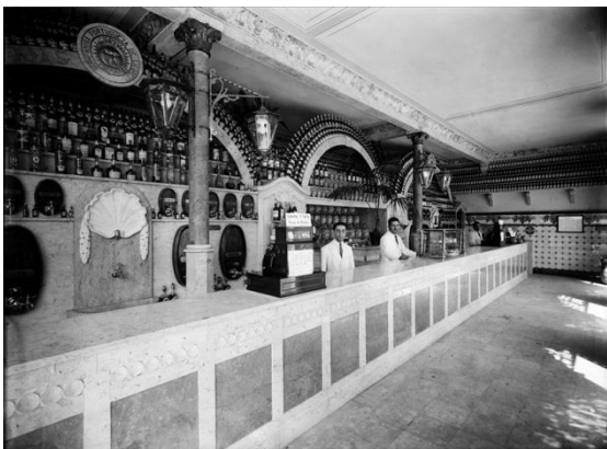
Fig. 96 – Estabelecimento Val do Rio, no Poço do Bispo – 1928.
