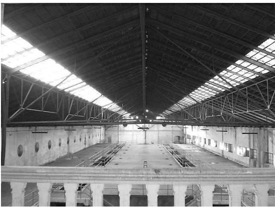
Fig. 189 – Vista para o armazém 2.
