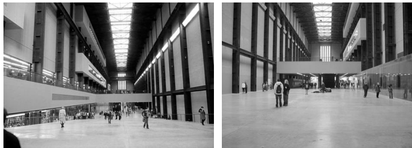
Figs. 10 e 11 – Sala das turbinas após intervenção.
