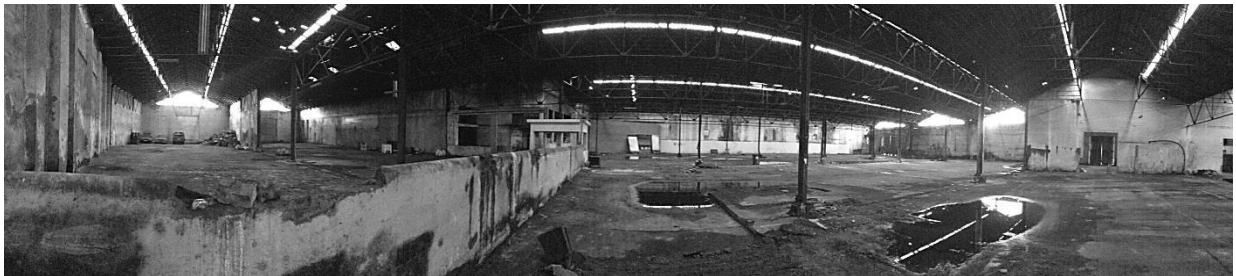
Fig. 145 – Panorâmica dos armazéns 11, 14, 15, 16, 17, 18 e 19.
