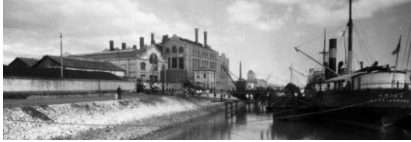
Fig. 18 – Processo de descarregamento do carvão.
