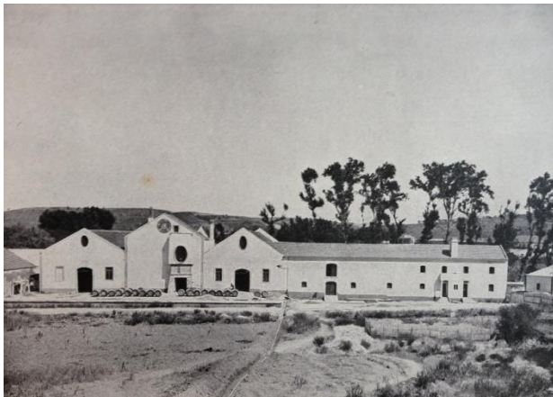
Anexo 8 – Dois Portos, Armazém e cais privativo, 1928.
