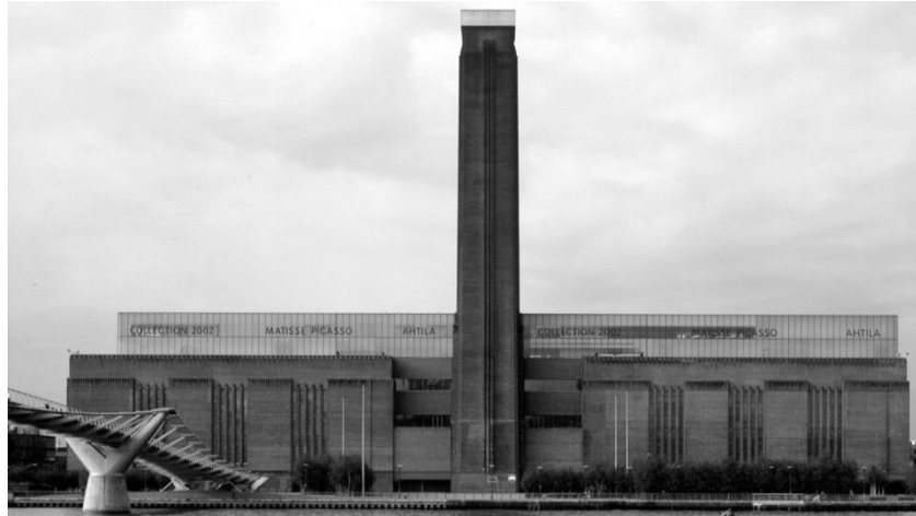
Fig. 9 – Vista exterior após intervenção.
