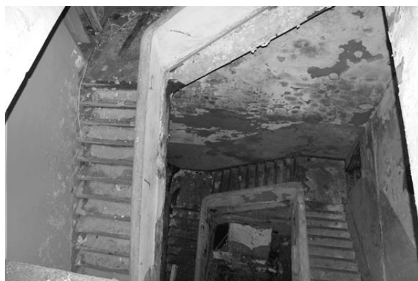
Fig. 203 – Núcleo de escadas / antigo elevador.
