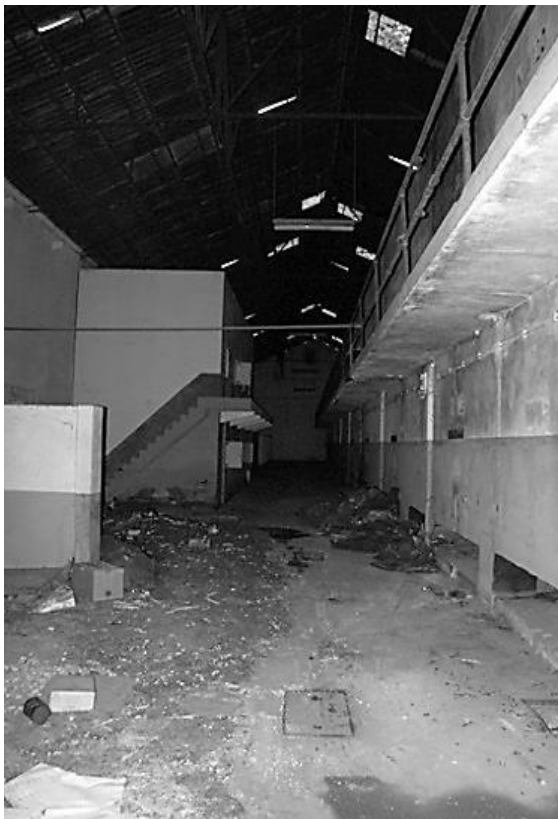
Fig. 119 – Galeria de Cubas.
