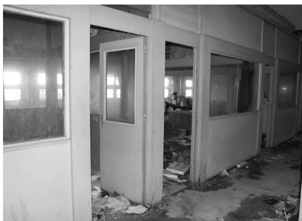
Fig. 204 – Entrada para os gabinetes.
