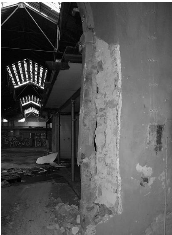
Fig. 135 – Entrada este, armazém 8.
