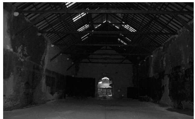
Fig. 137 – Entrada oeste, armazém 8.
