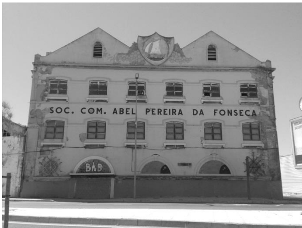
Fig. 215 – Edifício de escritórios.
