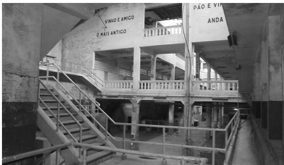
Fig. 164 – Vista para a entrada Norte.
