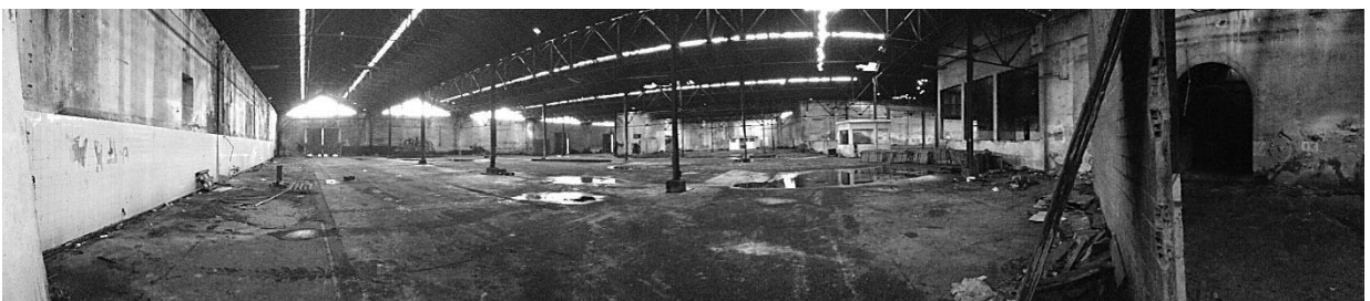
Fig. 146 – Panorâmica dos armazéns 11, 14, 16, 18 e 19.
