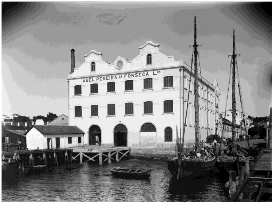
Fig. 61 – Instalações da firma Sociedade Comercial Abel Pereira da Fonseca em 1923.
