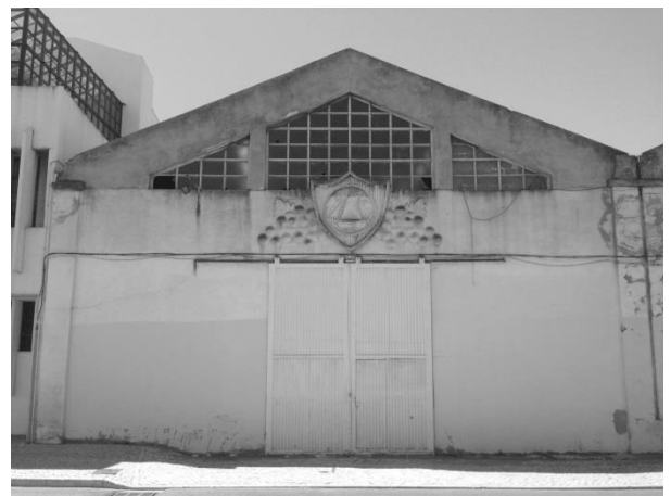
Fig. 216 – Pormenor no último armazém da Rua Cintura do Porto.
