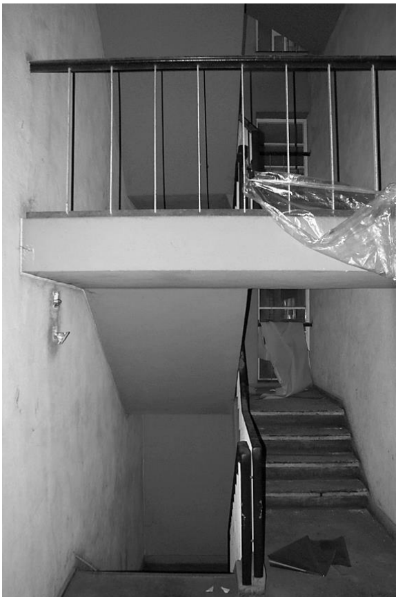
Fig. 185 – Núcleo de escada entrada Este.
