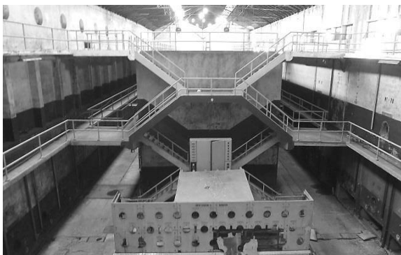
Fig. 176 – Vista para o armazém 2.
