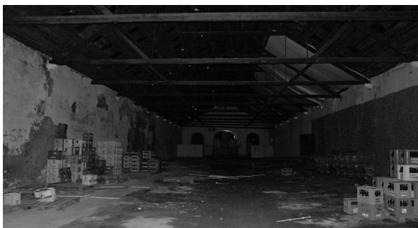
Fig. 139 – Entrada este, armazém 10.
