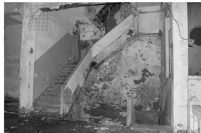
Fig. 187 – Núcleo de escada/ antigo elevador.
