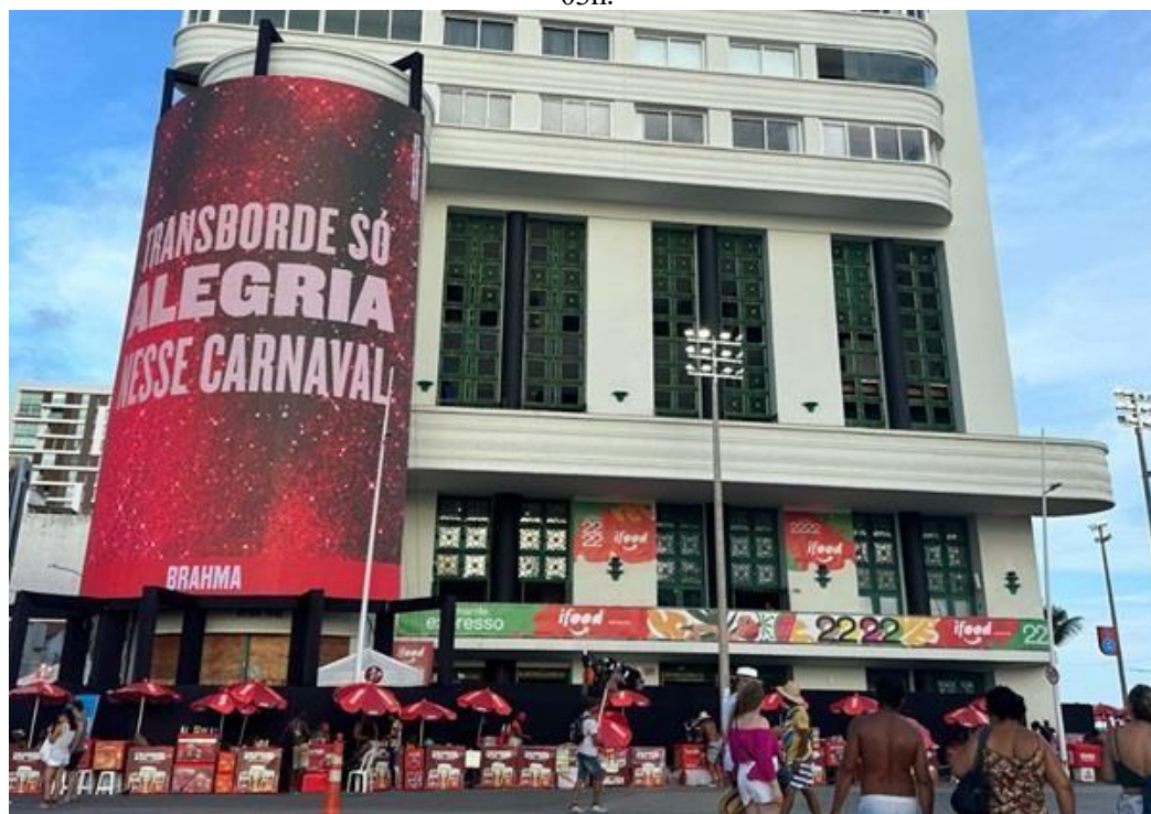
Figura 10 - Pannel de LED instalado na fachada do Edifício Oceania, no Farol da Barra, o telão 3D estreou no dia 3 de fevereiro e ficou ativo por 10 dias, até o dia 13 de fevereiro, das 15h às 03h.
