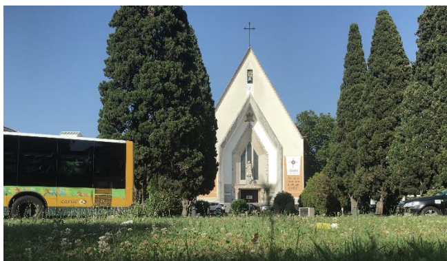
Img. 78: foto desde o nó de circulação viário em direção a Igreja São João de Brito.
