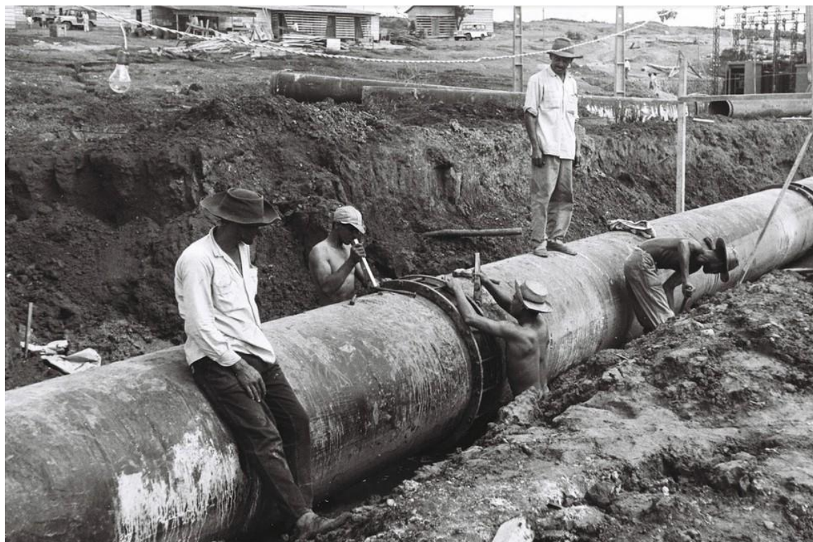
Figura 52 - Operários na construção da barragem do Lago Paranoá — Foto: Arquivo Público do Distrito Federal.
