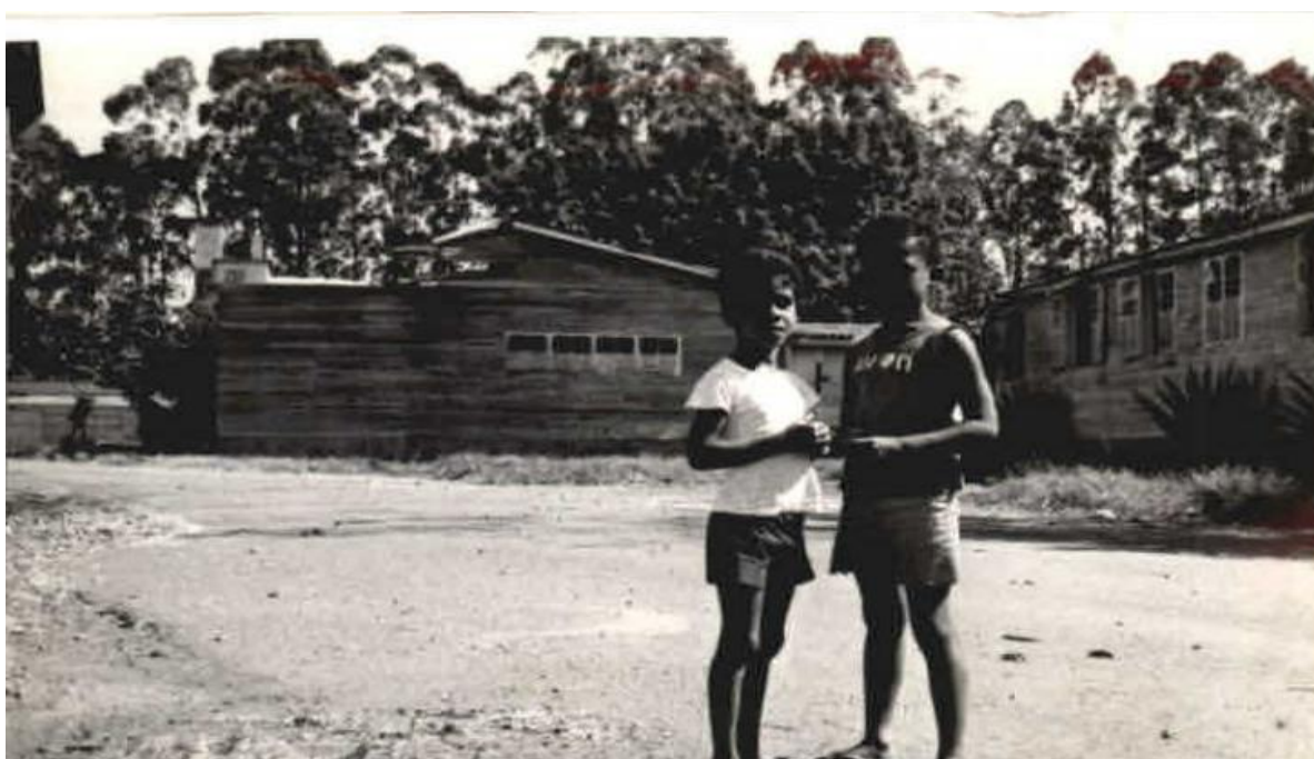
Figura 27 - Crianças do acampamento HJKO em frente ao edifício do antigo hospital. Fotografia que compõe o conjunto de documentos remetidos à Diretoria de Tombamento e Conservação do Sphan/Pró-Memória no parecer do pedido de tombamento deferal do HJKO, em 1984. Fonte: Iphan nº 1099-T-83/Volume I.
