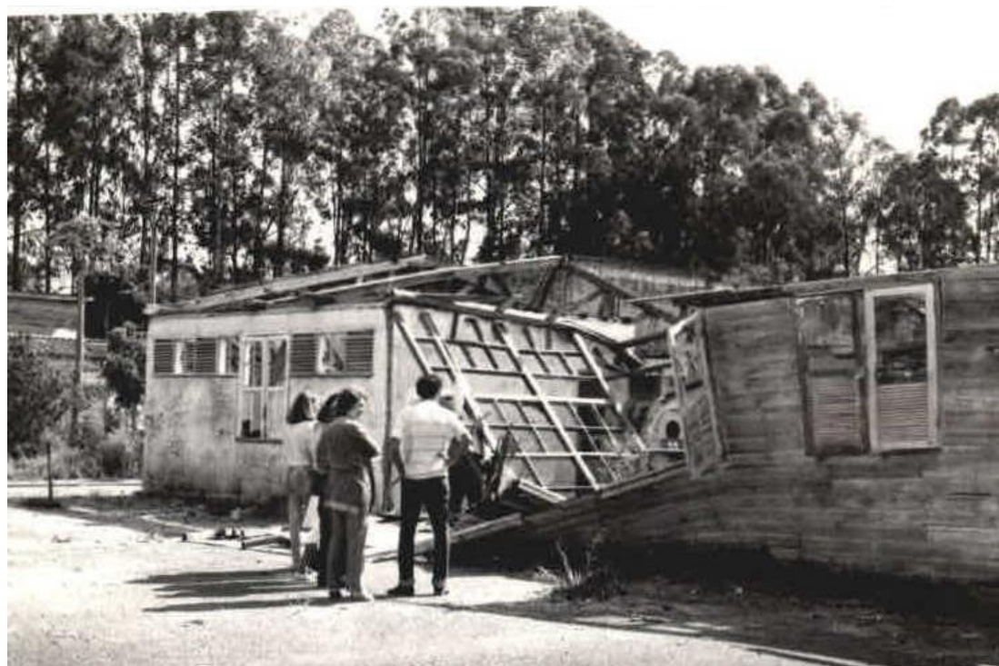
Figura 29 - Foto do pavilhão B do HJKO, parcialmente caído, que consta em parecer do pedido de tombamento federal do conjunto em 1984. Fonte: Iphan nº 1099-T-83/Volume I.
