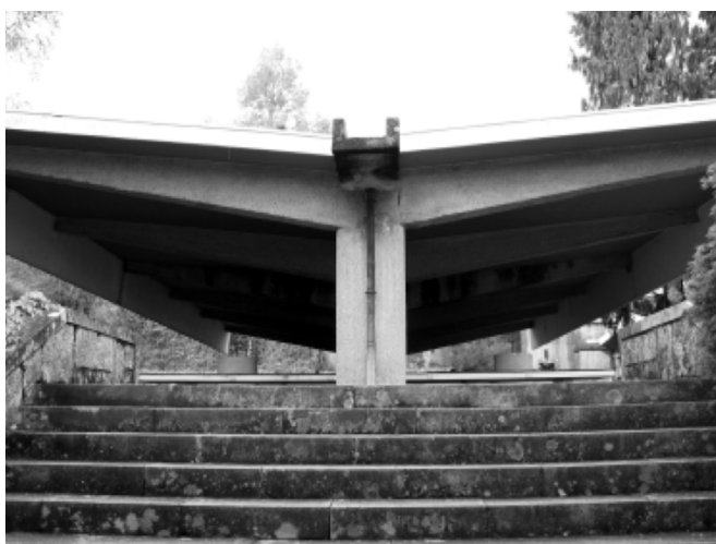
Fig.22 – Cobertura em Betão, asa de borboleta.
