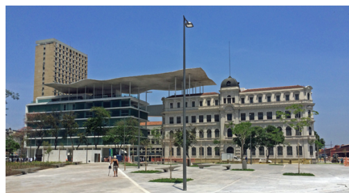
Fig.34 – Vista real praça.
