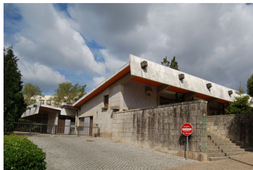
Fig.48 – Vista Rua principal, Mercado da Feira.
