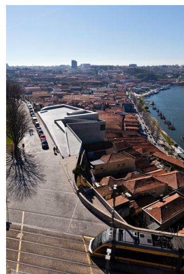
Fig.40 – Vista de acesso Estação Alta.
