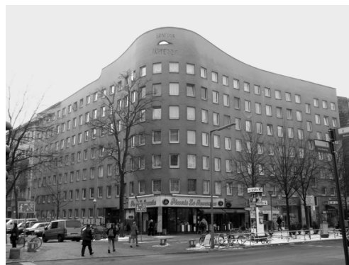
Fig.28 – Vista esquina curva, Edifício Kreuzberg.
