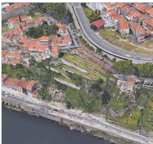
Fig.59 – Reconstrução Passeio das Fontainhas.
