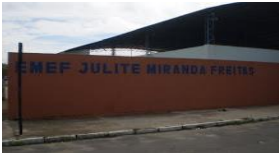
Fotografia 1 -Escola do município da Serra/ES “EMEF Julite Miranda Freitas”
