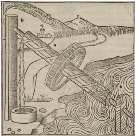
Figura 32 - Fra Giocondo procura ilustrar o “parafuso de Arquimedes”, mas não refere as relações que aquele estabelece entre a altura e o comprimento, isto é não refere a referência de Vitruvio, mas antes uma interpretação temática do capítulo.
