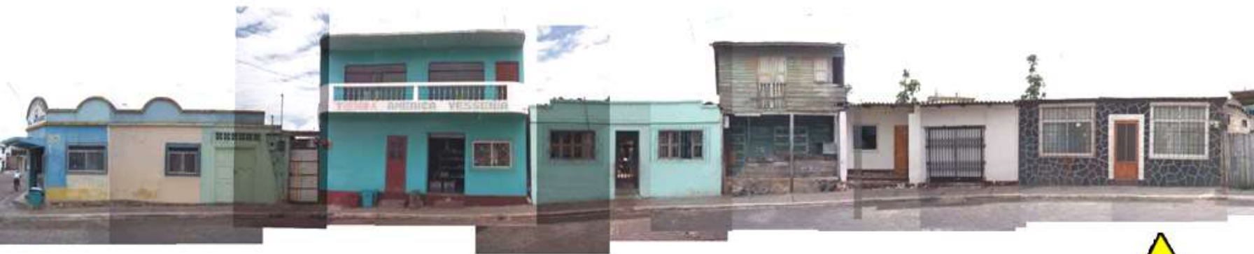
PADRÃO FACHADAS EXISTENTE
