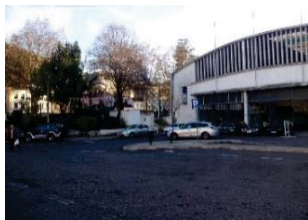
Figura 94 – Fachada da Gare Rodoviária voltada para a praça de táxis.
