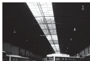
Figura 68 – Interior da gare rodoviária. (Correia, 2013)
