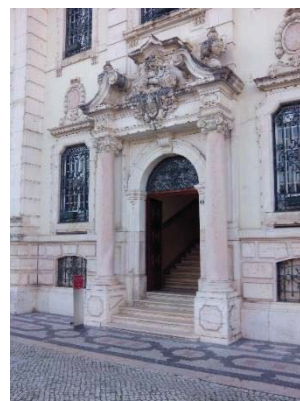
Figura 107 – Entrada principal, Banco de Portugal.
