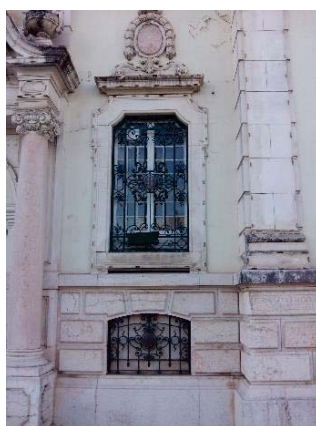
Figura 82 - Pormenor de uma das janelas e do alinhamento que existe na fachada principal. (Damásio, 2013)
