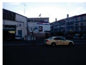
Figura 97 – Vista parcial da fachada norte da Gare.
