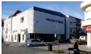
Figura 61 – Fachada direita do edifício Garage, voltada para a Avenida Heróis de Angola.
