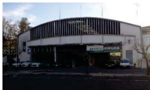
Figura 95 – Fachada Norte onde atualmente está instalado uma oficina de Renault.
