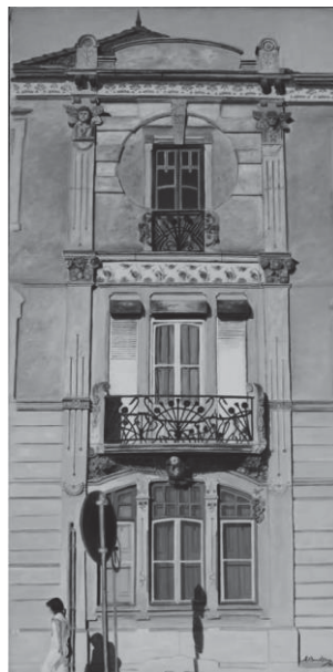
Figura 62 – Pormenor da fachada do Edifcio Garage, do construtor civil, Augusto Romo. (Correia, 2013)
