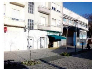
Figura 96 – Fachada Sul da Gare Rodoviária, voltada para o Jardim Luís de Camões.
