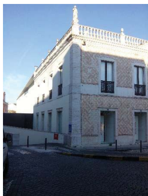
Figura 105 – Fachada principal do Antigo Paço Episcopal.
