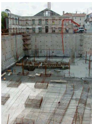
Figura 74 – Obras efetuadas no edifício do Paço Episcopal. Imagem de João Mascarenhas Mateus, 2011.
