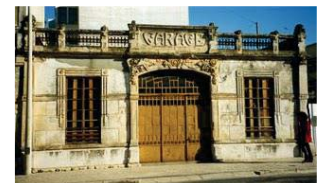
Figura 59 – Parte da fachada antiga do edifício Garage. (Costa L. V., 1989)
