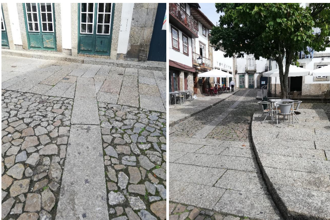
Figura 22 - Interseção de pavimentos da guia central da faixa rodoviária para as lajetas de granito polido na Rua de Santa Maria; Uso das lajetas de granito para demarcar zona pedestre. Fonte: Autor.
