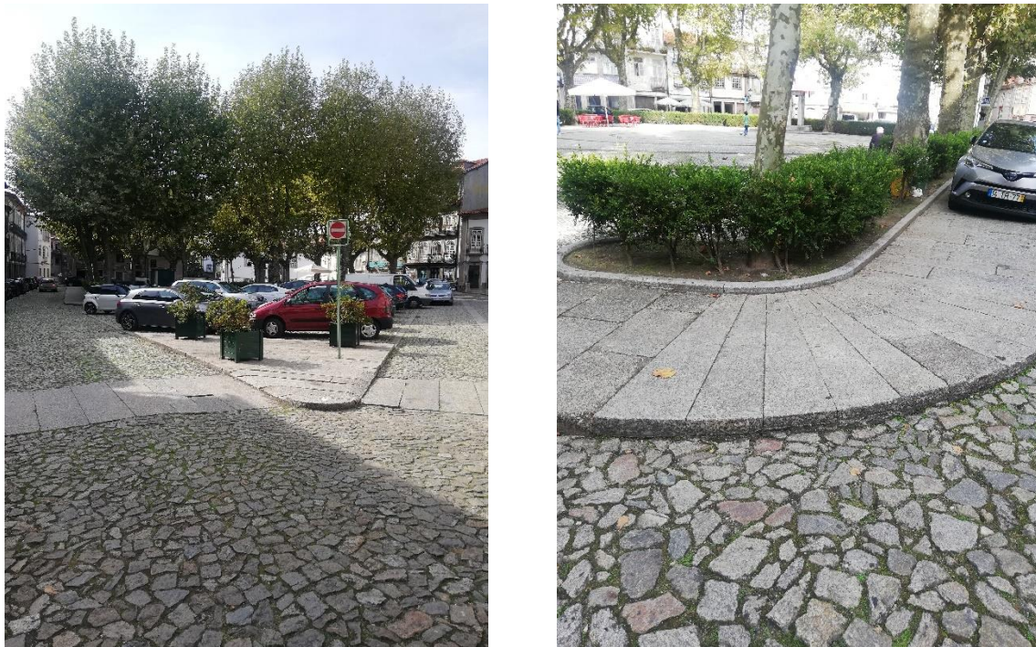
Figura 40 - Vista para o estacionamento do Largo; Pormenor remate do passeio. Fonte: Autor.
