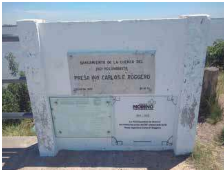
Figura 6: Placas conmemorativas ubicadas sobre el muro del coronamiento de la represa Roggero. Foto: Fernando Williams.
