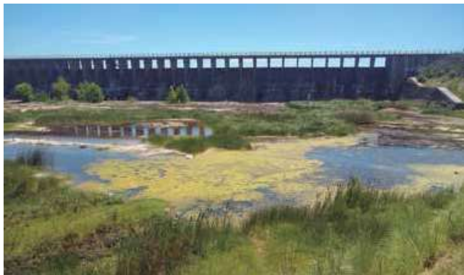
Figura 4: Parte central de la represa Roggero donde se ubican los vertederos, vista desde río abajo. Foto: Fernando Williams.
