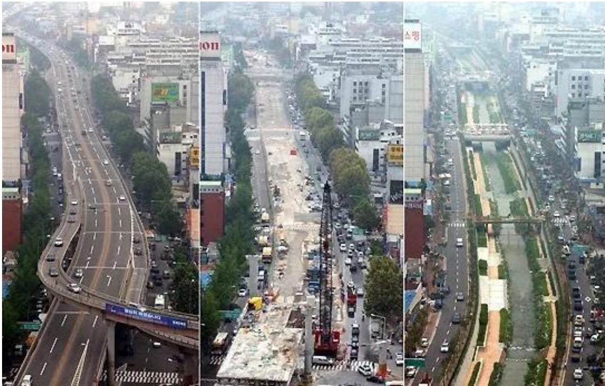
Figura [40] Imagem representativa do antes, durante e depois das obras.
