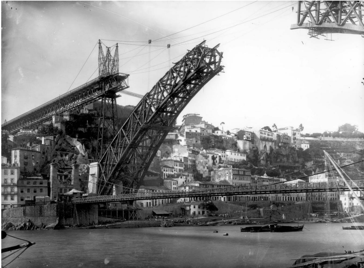
Figura [6] Fotografia da construção em curso da ponte Luis I, 1881-1885. Disponível em: https://paginas.fe.up.pt/~azr/pontes/pontes.htm
