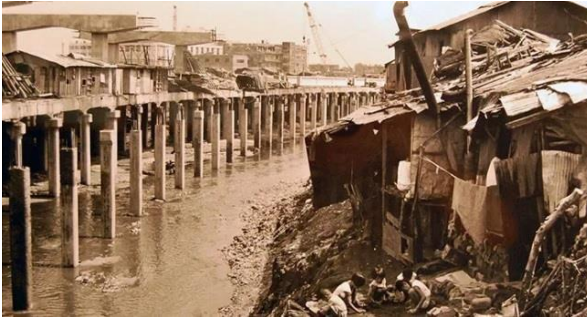
Figura [38] Imagem representativa no decorrer das obras do viaduto. Início da década de 60. Disponível em: http://www.viveraviagem.com.br/cheonggyecheon/
