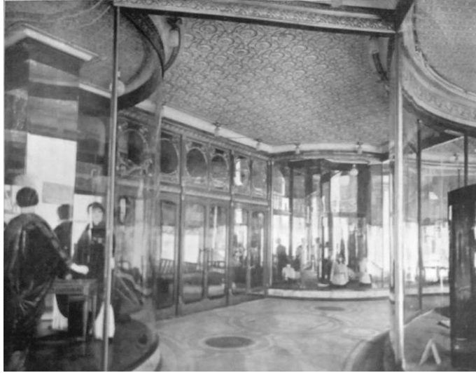
FIG. 3. Galleries Lafayette. Opera gate. Paris, 1912 (Photo: Arquitectura y Construcción)
