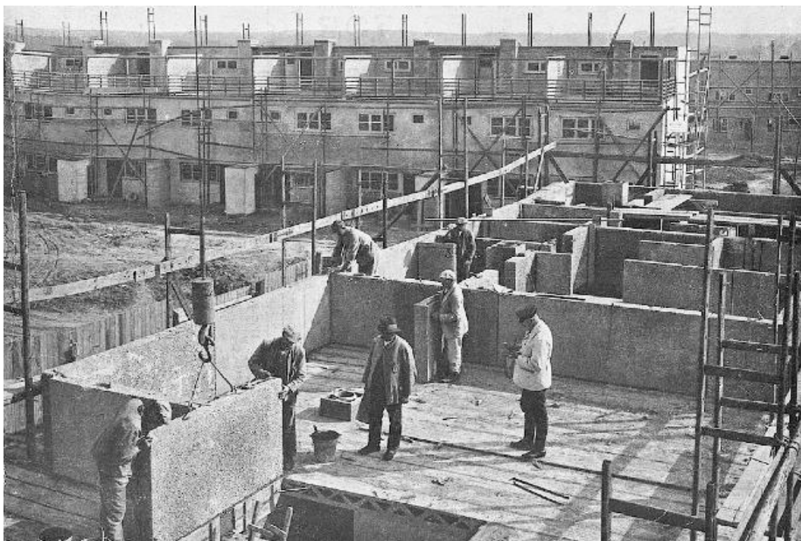
Fig. 11- Sistema de montagem de painéis pré-fabricados utilizado em Frankfurt, este sistema permitia a construção rápida dos elementos estruturais das habitações, graças à utilização de modelos produzidos em série.
