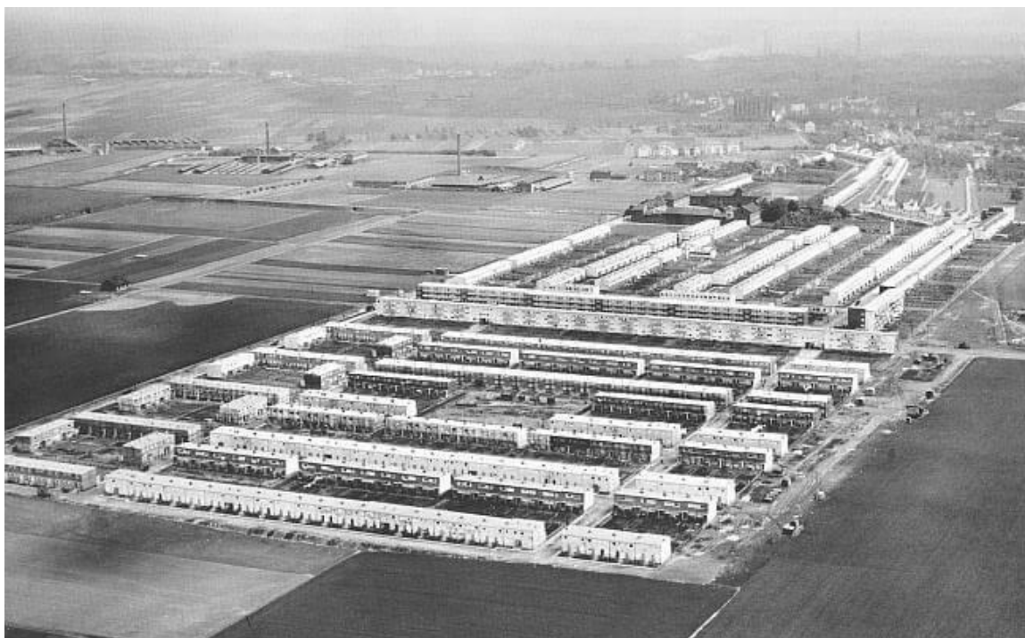
Fig. 12- Imagem aérea dos novos bairros, é possível observar os novos traçados modernos dos quarteirões elaborados por Ernst May.
