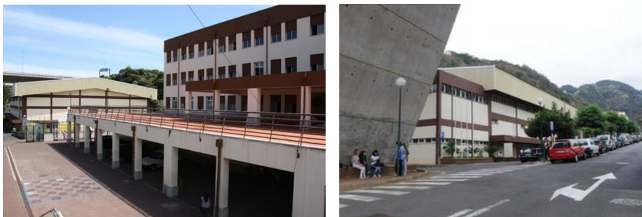
Fig. 4 e 5: Fachada do edifício da Escola Básica e Secundária de Santa Cruz.
